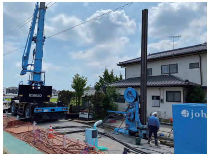
音を少なく矢板を打ち込む工法
