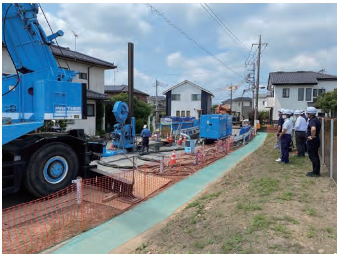
工事現場を視察するようす
